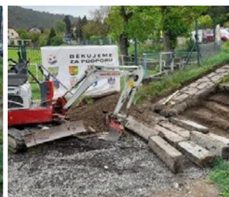
Probíhající rekonstrukce schodiště
