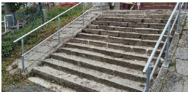
Schodiště k Bojovskému potoku po rekonstrukci
