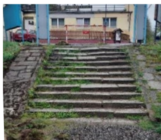
Stav schodiště před rekonstrukcí
