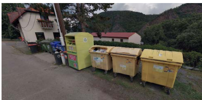
Původní stav místa pro kontejnery u OÚ
