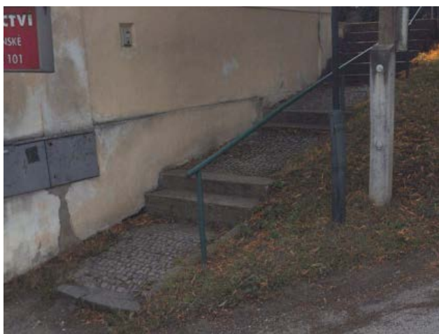
Schodiště u OÚ stav před rekonstrukcí
