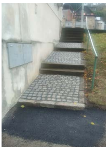
Schodiště u OÚ stav po rekonstrukci
