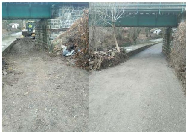
Podjezd mezi brody při rekonstrukci
