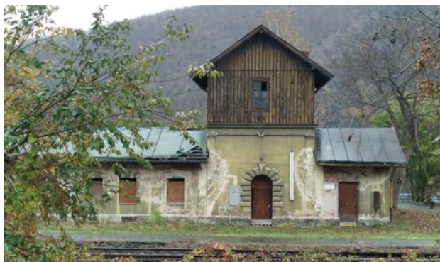
Objekt vodojemu na nádraží
