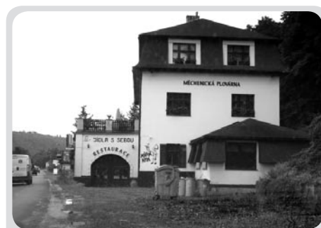
Budova č. p. 5
