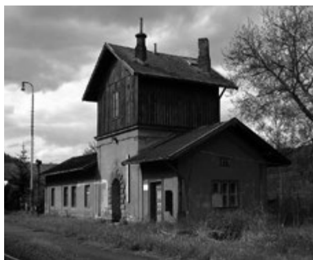
Vodárna v roce 2013, stav před sejmutím komínů a poškozením fasády
